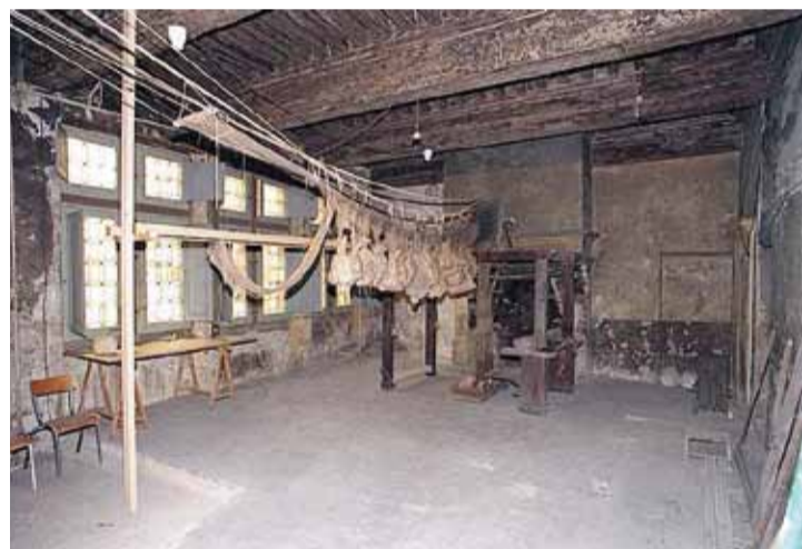
Sehenswürdige Säle, Bestand 2002 (vor den Restaurierungsmaßnahmen)
